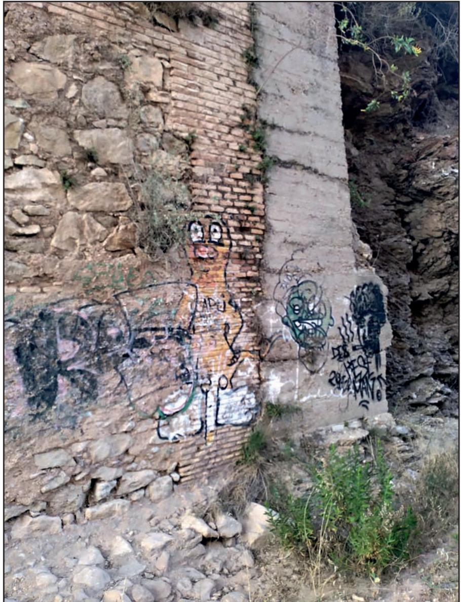
A la izquierda uno de los antiguos muros de carga del Puente Nuevo del Siglo XIX, realizado en mampostería y ladrillo macizo. A su derecha un añadido de hormigón que se añadió para ampliar su estructura.
