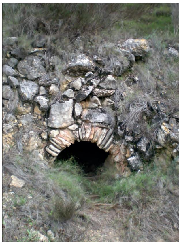
DETALLE DE LA BOCA DEL MINADO DE LA CAÑADA DE LA PERDIZ CON ARCO Y DOVELAJE EN MAMPOSTERÍA CON MORTERO DE CAL. (FOTO ARQUEALIA).
